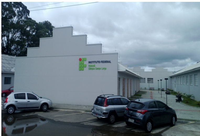
Figura 3. Parte das construções da antiga cerâmica foi modificada para a construção das salas de aula.
