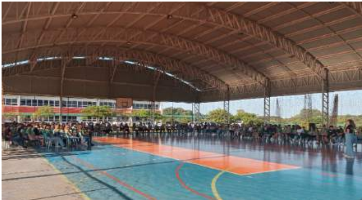
Figura 16 - Quadra Poliesportiva - IFPR - Câmpus Capanema
