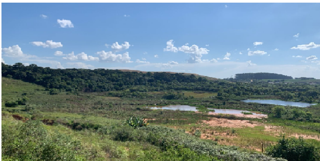
Figura 1: Área de depósito de água provenientes do Aterro Sanitário de Fazenda Rio Grande
