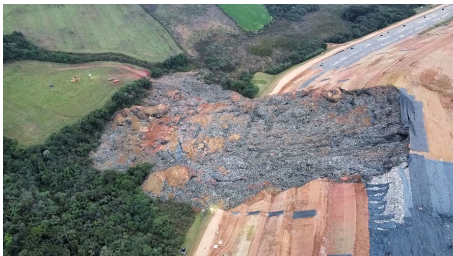
Figura 3: Aterro sanitário de Fazenda Rio Grande após o deslizamento
