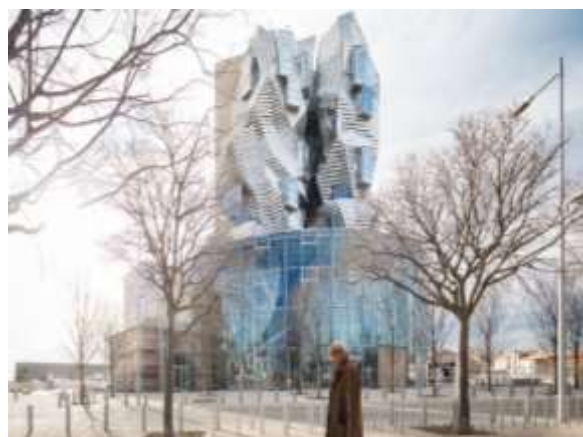
Figura 6: Torre Luma Arles
