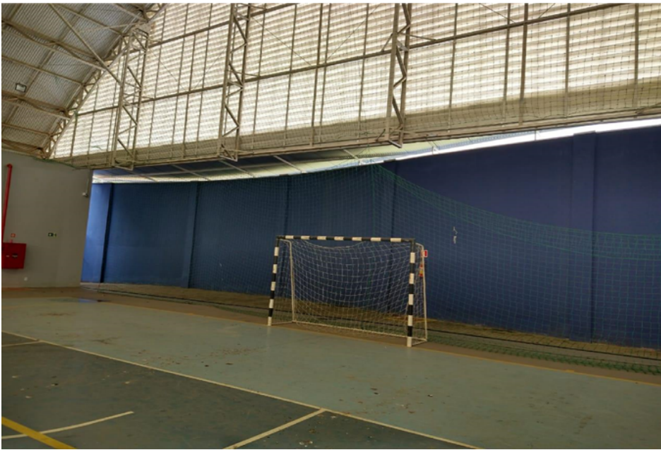
Cobertura do Ginásio de Esportes
