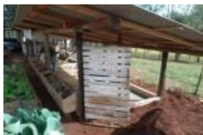
Figura 1: Alojamento para as 120 aves em fase de construção.
