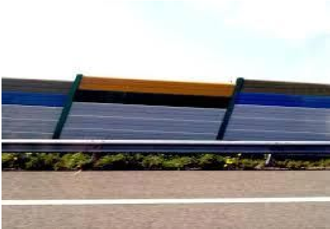
FIGURA 7. Exemplo de Barreira Acústica ao longo da A1( Portugal).
