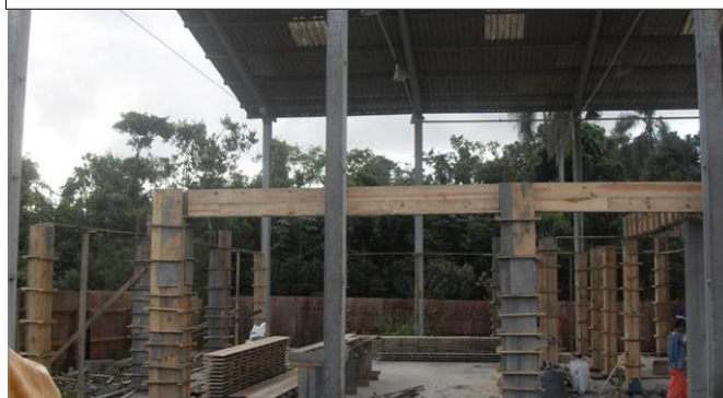
Construção do Laboratório de Meio Ambiente, ao fundo a Reserva Legal do Câmpus.
