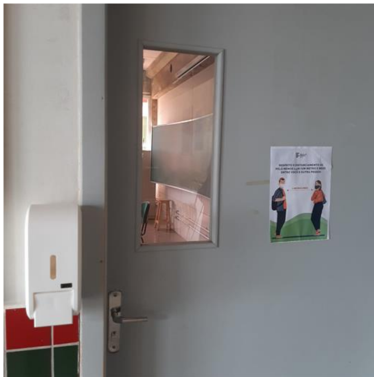
FOTO 13 – Dispense de Álcool Gel nas entradas das salas de aulas
