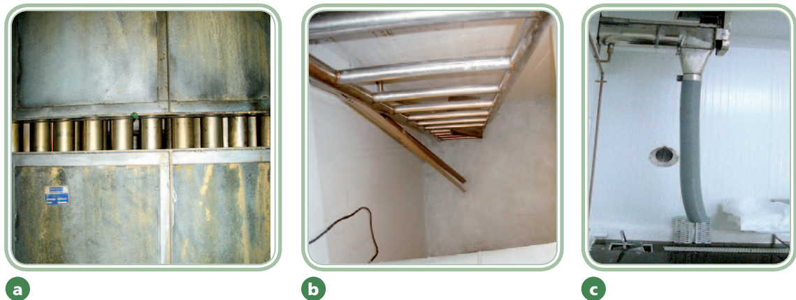
Figuras 3.23: (a) Tubos de congelamento da água da máquina produtora de gelo, (b) câmara de armazenagem e (c) Duto plástico transportador de gelo
