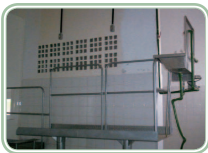
Figura 4.8: Plataforma metálica elevada com esterilizador e pias para lavagem das mãos
