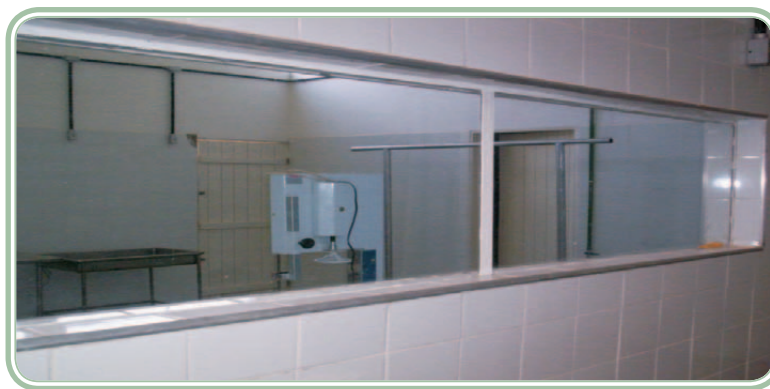
Figura 4.10: Sala de desossa climatizada
