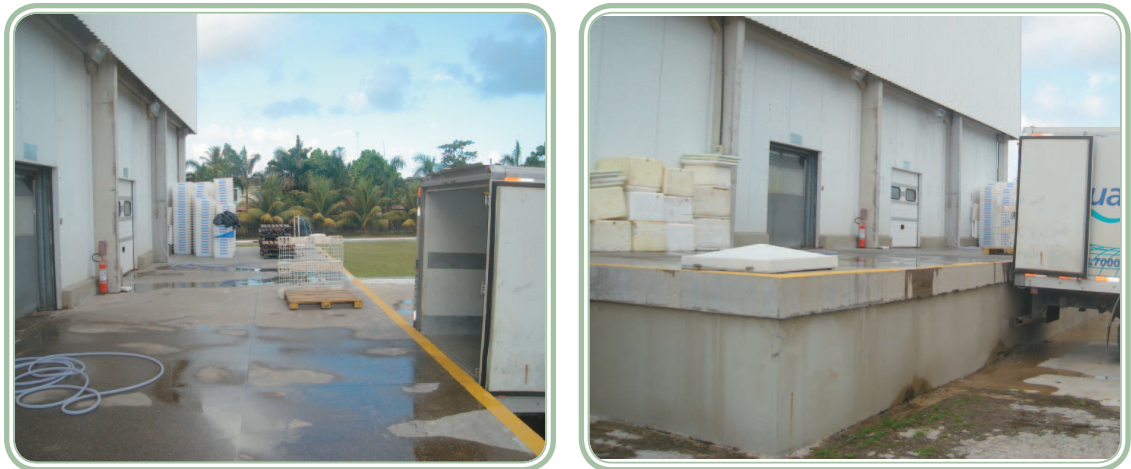
Figura 3.7: Docas de recepção adaptadas à altura dos caminhões de entrega de matéria-prima com aproveitamento da área para construção de cisterna
