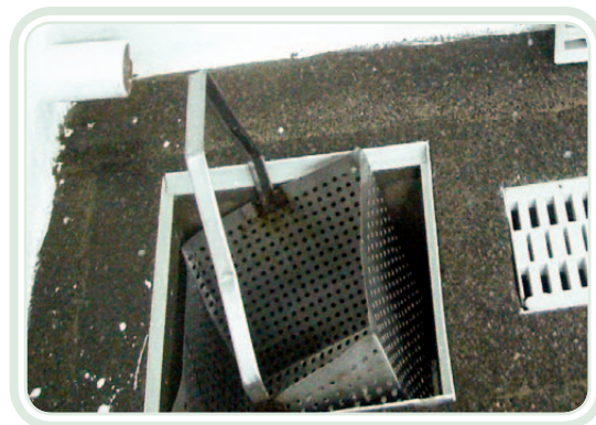
Figura 1.2: Piso monolítico com inclinação direcionada para canaletas
