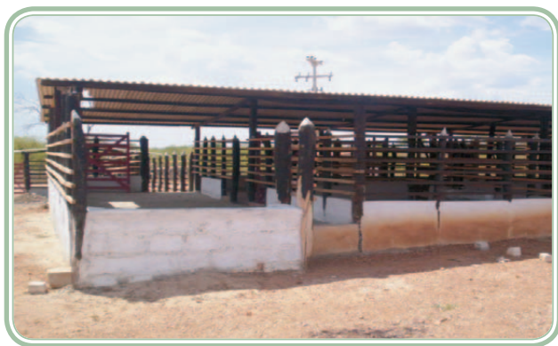
Figura 4.3: Currais de um matadouro de pequenos e médios animais dotado de cordão sanitário construído em alvenaria.
