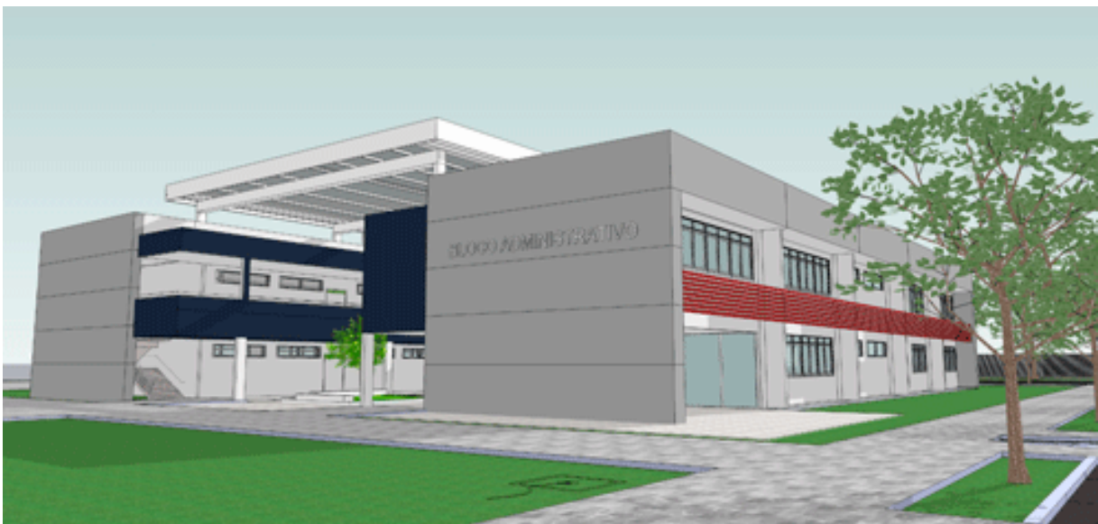
Figura 68 – Bloco Administrativo em implantação
