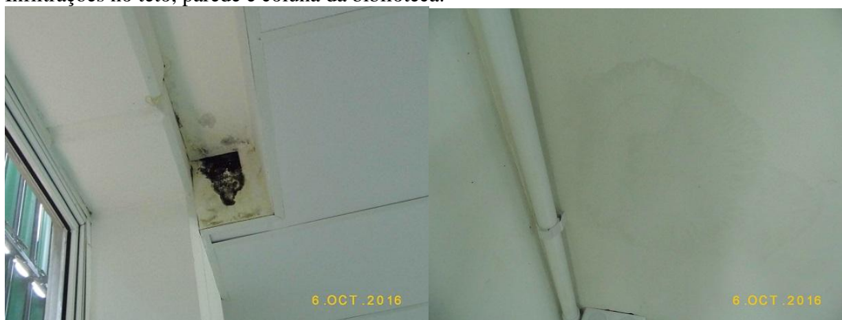
Infiltrações no teto, parede e coluna da biblioteca:
