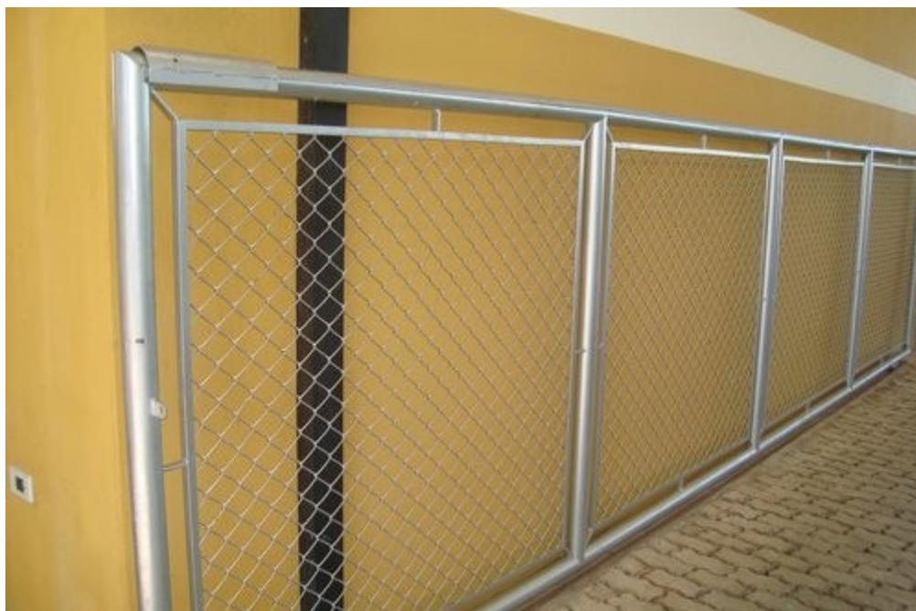
*Figura 1: PORTÃO EM TUBO DE FG E FECHAMENTO COM TELA LOSANGULAR*
