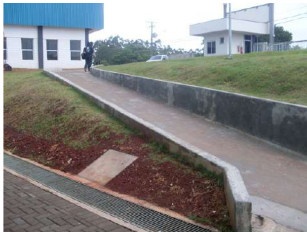
Rampa externa de acesso ao Bloco Didático
