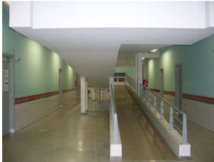
Rampa de acesso ao segundo piso do Bloco Didático
