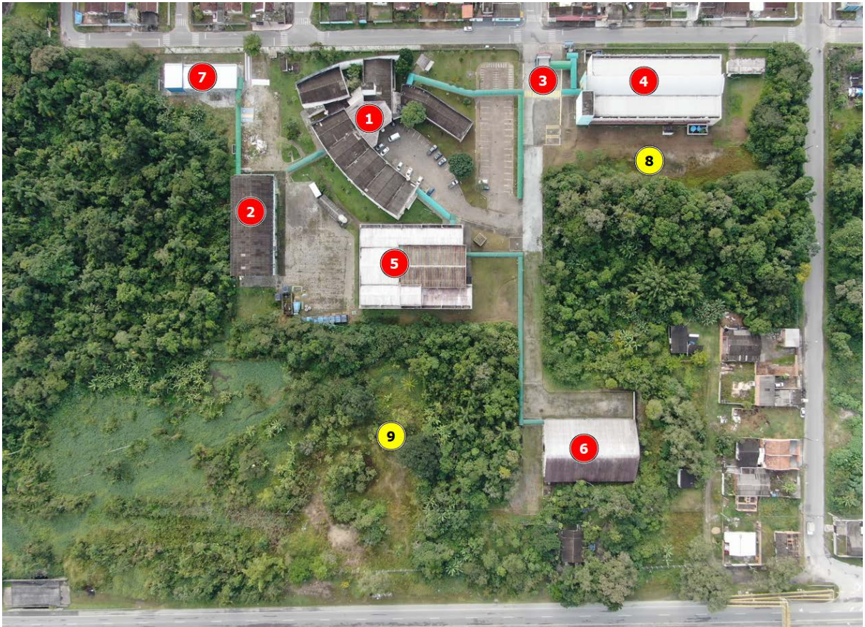
Figura 3.1: IFPR Campus Paranaguá - Rua Antônio Carlos Rodrigues, 453, Bairro Porto Seguro, Paranaguá - PR, CEP 83215-750
